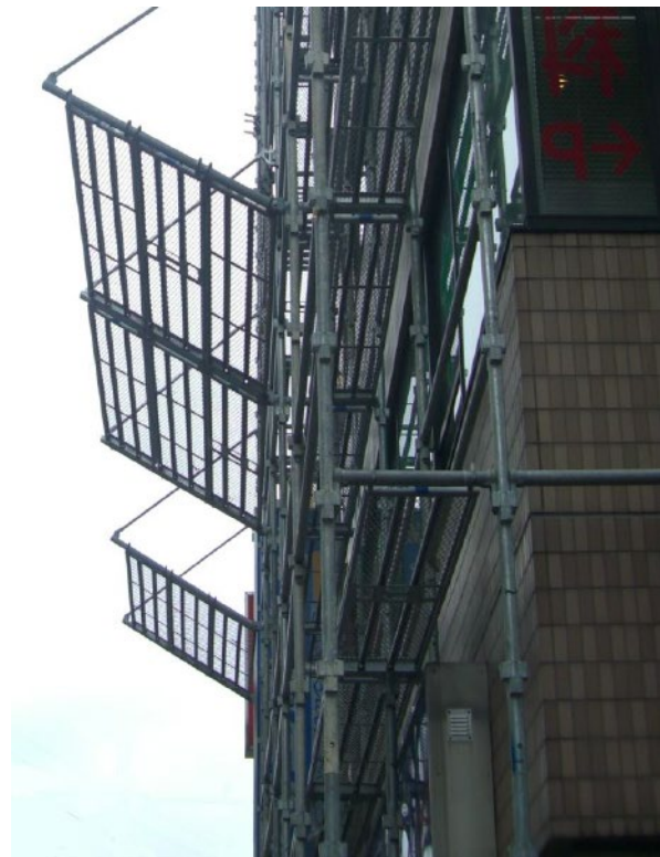
④ 隣接したスパンに同様の手順で取り付け、踏板を手前から設置する
